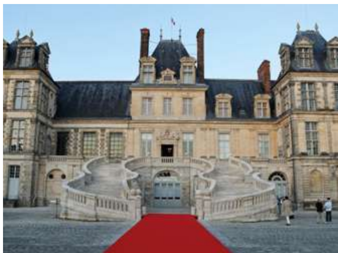
Escalier dit « en Fer-à-Cheval »
